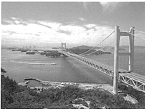
瀬戸大橋 倉敷 HP より
