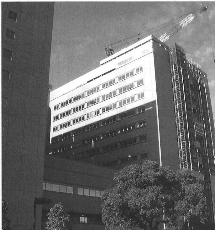
上は計画図面を下は2004年12月現在の建設中写真を示す。新病院への移設は2006年3月の予定
